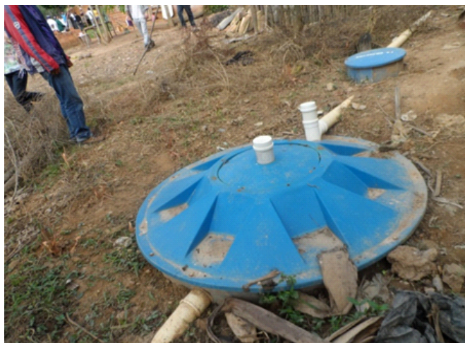
Figura 10 – A fossa séptica instalada no quintal de uma casa de Água Quente próxima ao Passa Sete. Se houver vazamento, o efluente segue para o rio. Fonte: GESTA.
